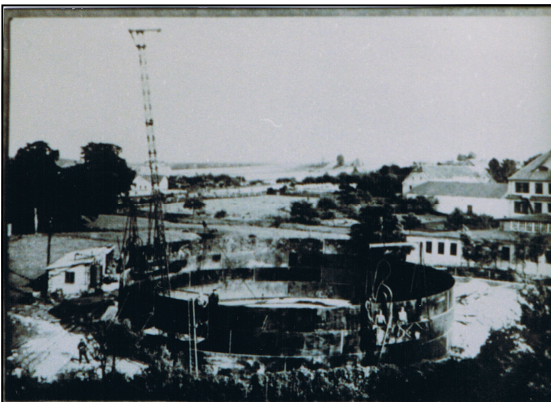
Abb. zeigt den Bau eines Gasometers mit Blick zu den Jesauer Wiesen
