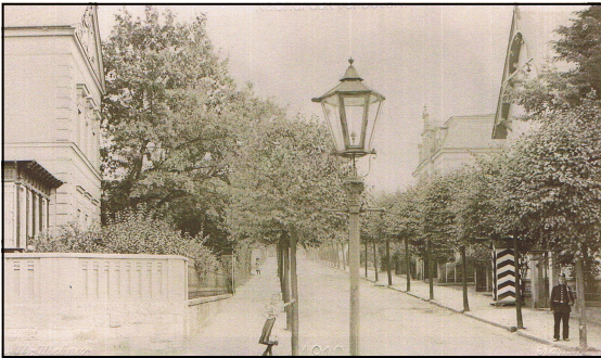
Abb. Links zeigt eine Straßenlaterne an der Ecke Haydn- (ehemals Wettinstraße) /Oststraße. Das Schilderhäuschen für den Soldaten an der rechten Straßenseite deutet darauf hin, dass in dem Gebäude der Regimentskommandeur der 178er wohnte
