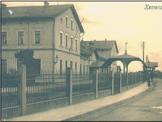
Abb. zeigt an der Ecke des Bahnhofsgebäudes zum Bahnsteig der Züge nach Elstra/Bischofswerda eine Gaslaterne
